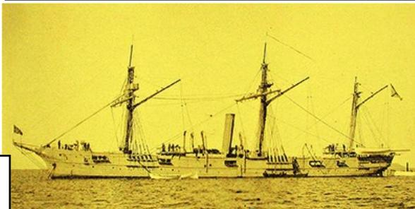
→1879年サンクトペテルブルクで進水。全長70m・排水量1360トン・速力13ノット
