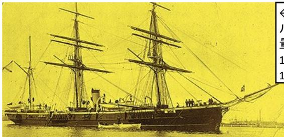
←1877年サンクトペテルブルクで進水。全長70m・排水量1334トン・速力12ノット
